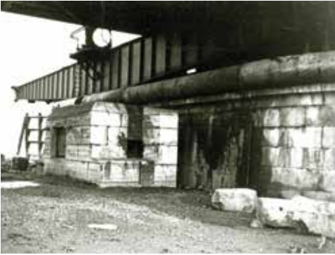
B-kazemat nr. 145 tegen een van de pijlers van IJsselbrug. De kazemat is als camouflage beschilderd als de natuursteenblokken van de brugpijler. Op de pijler rust de geopende draaibrug van de spooroverspanning, augustus 1940. (foto: J.J. Overwater, collectie Stichting Menno van Coehoorn)
